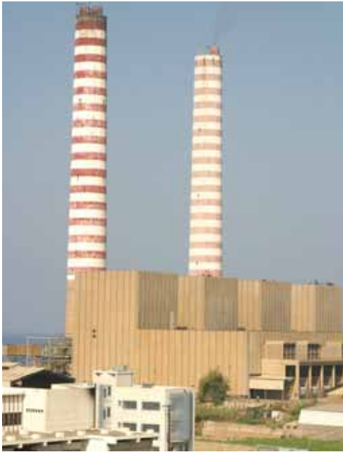
محطة توليد الكهرباء في زوق مكاييل
